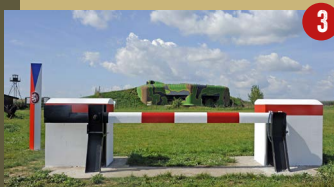
3 Pěchotní srub MJ - S 3 „Zahrada“
